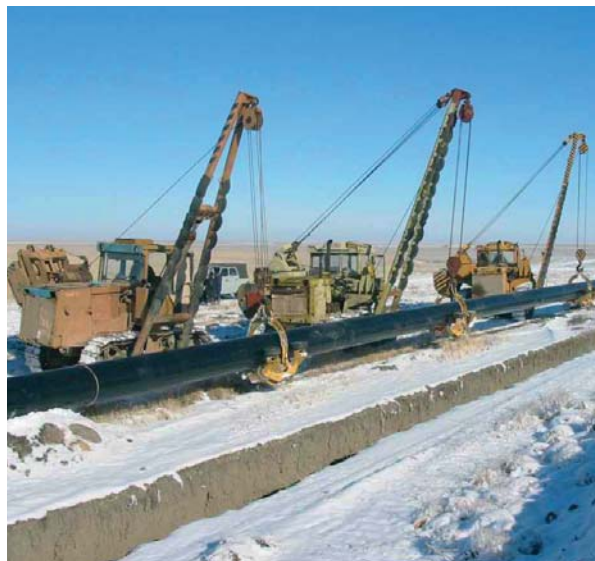
Нефтепровод Кенкияк-Атырау, Казахстан. Укладка плети в траншею
