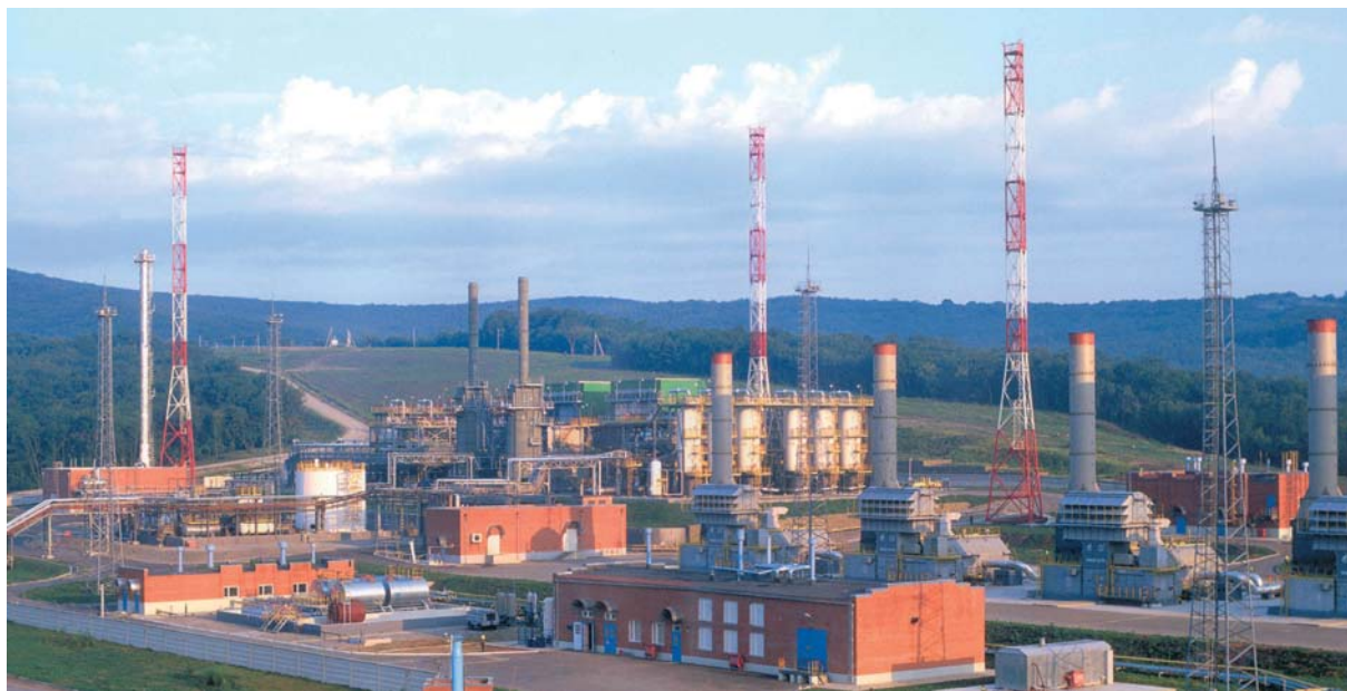
Газопровод «Голубой поток». КС «Краснодарская»
