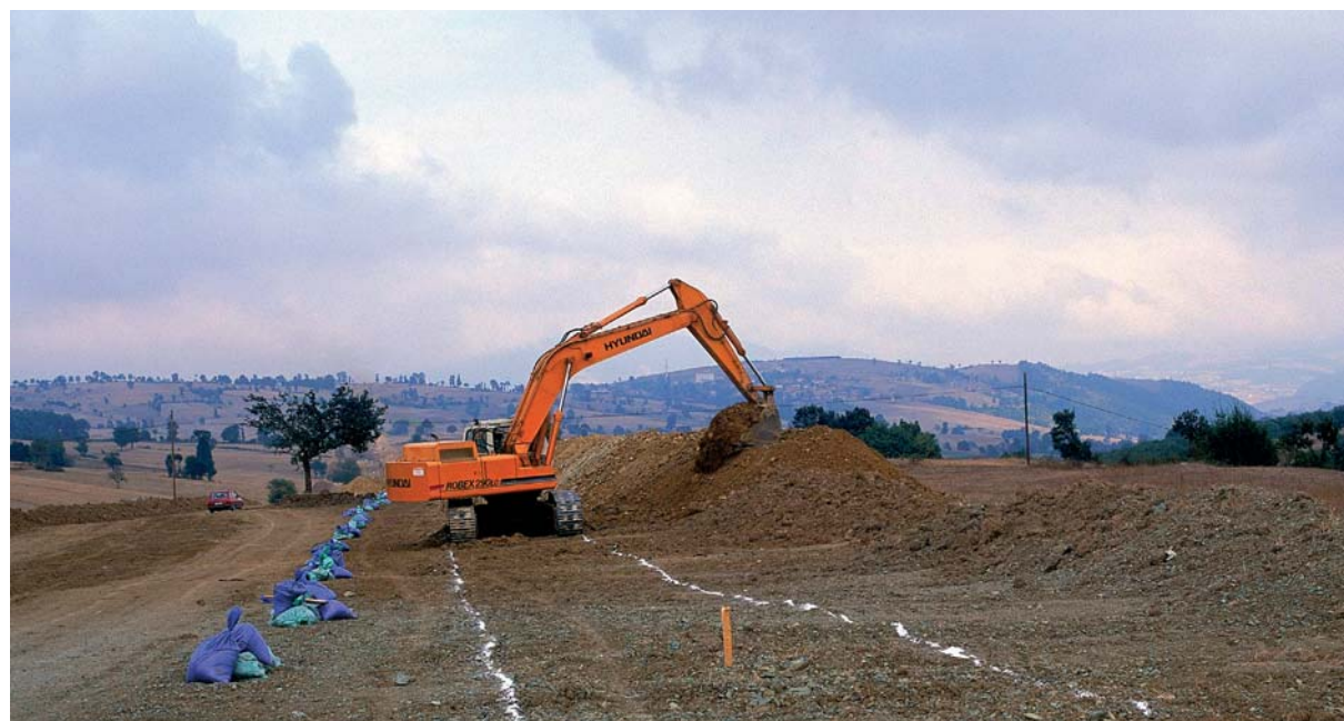
Газопровод «Голубой поток». Подготовка траншеи
