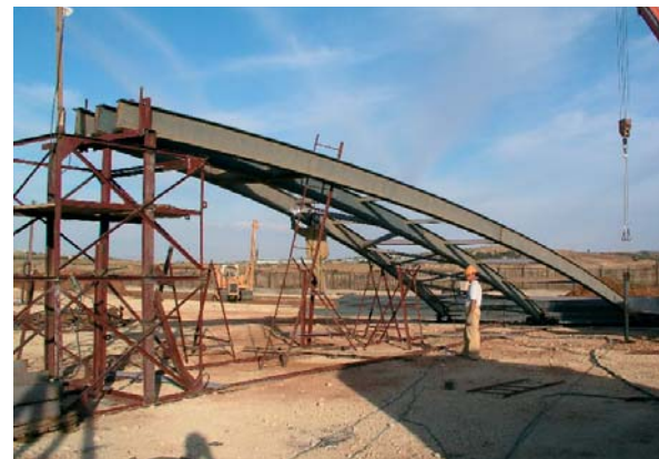
Нефтепровод Хауд-эль-Хамра-Арзев, Алжир. Монтаж резервуаров на станции понижения давления нефти “Кенанда”
