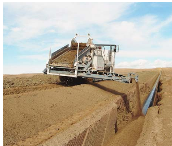
Газопровод GK-1 (Улед Джеллаль Скигда), Алжир. Засыпка траншеи
