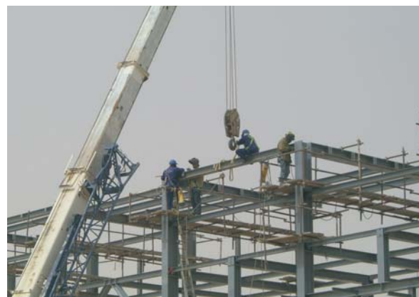
Юго-Западная ТЭЦ. Строительство главного корпуса
