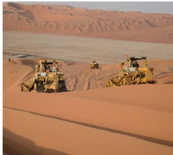
Нефтепровод Шейба-Абкейк, Саудовская Аравия. Подготовка трассы
