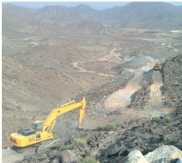
Газопровод Тавила-Фуджейра, ОАЭ. Разработка траншеи в горной местности
