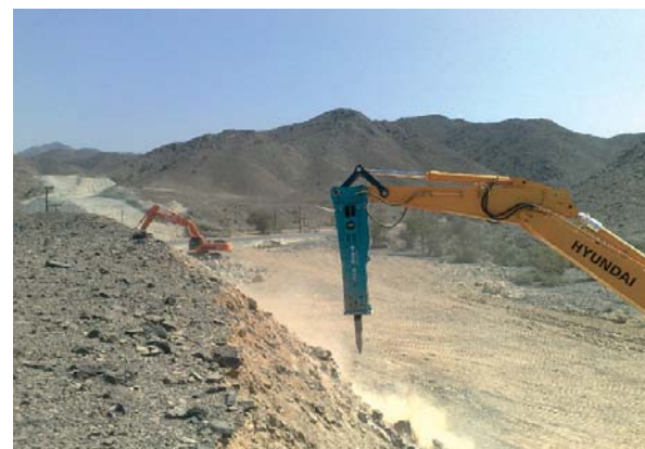
Газопровод Тавила-Фуджейра, ОАЭ. Разработка траншеи с использованием гидромолота
