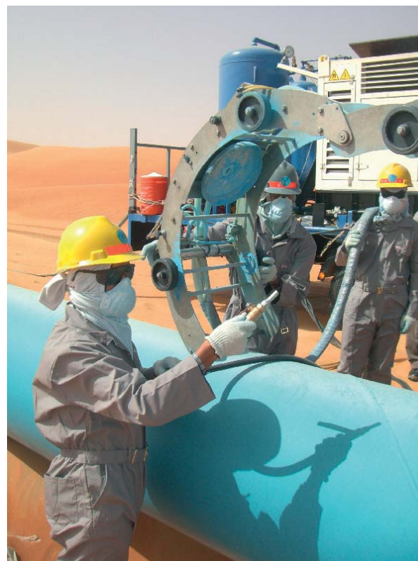
Нефтепровод Шейба-Абкейк, Саудовская Аравия. Нанесение изоляции
