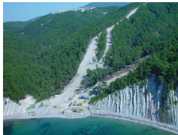
Газопровод «Голубой поток». Выход трассы трубопровода к морю
