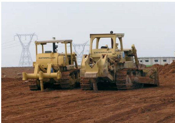
“Арабский газопровод”, Сирия. Расчистка полосы отвода
